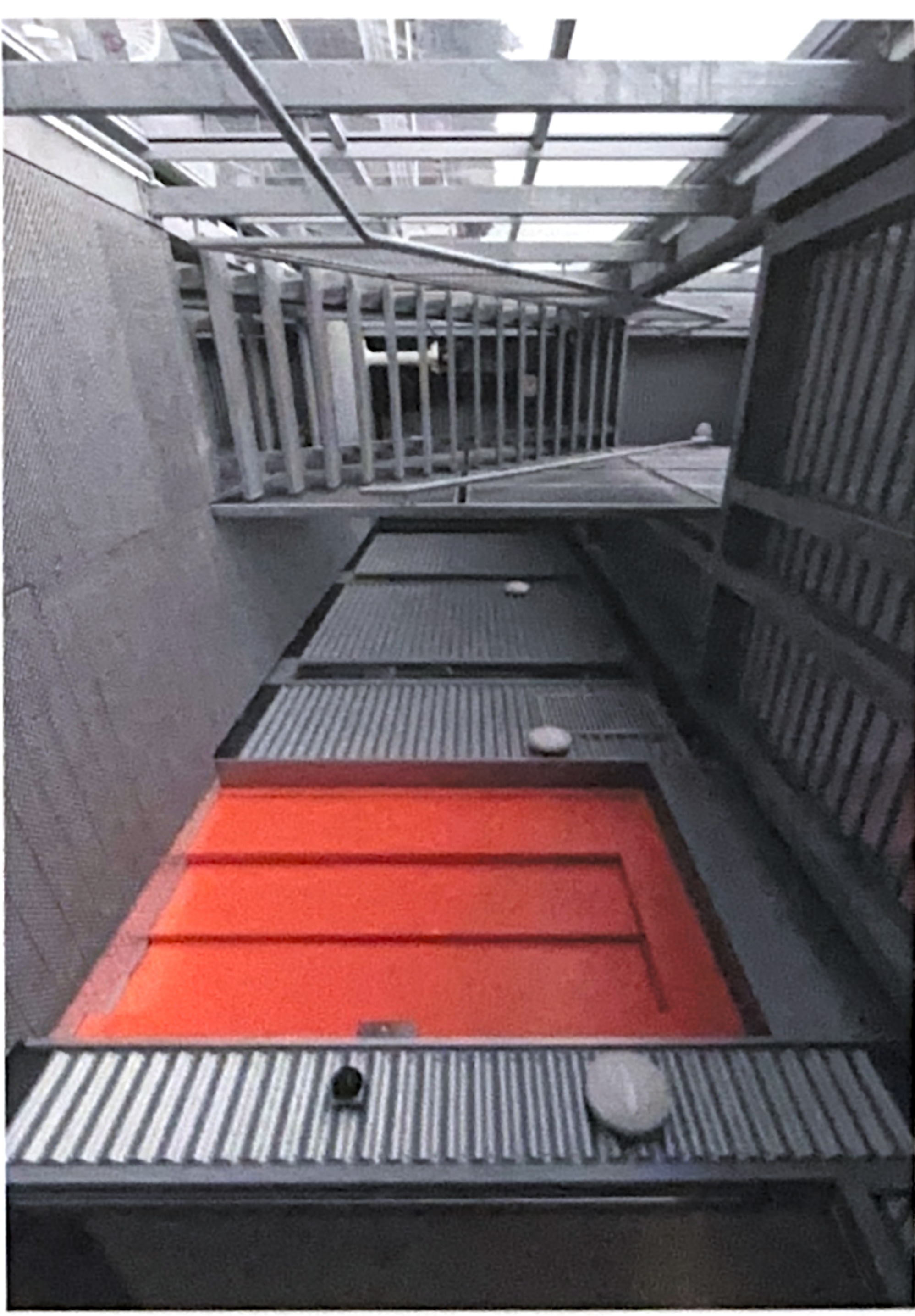
1 De oriëntatie van de appartementen geschiedt aan de achterkant van het blok. Ook hier zijn industriële materialen toegepast, zoals geperforeerde stalen vloerplaten en golfplaat. De ruimte rechts is een gemeenschappelijke ruimte waarvan de voordeuren van de woningen liggen. De oriëntatie is van de lift. 2 Aan de achterkant van het vierlaagse volume zijn nog twee woningen ondergebracht. Daartussen ligt een terras voor gezamenlijk gebruik.
