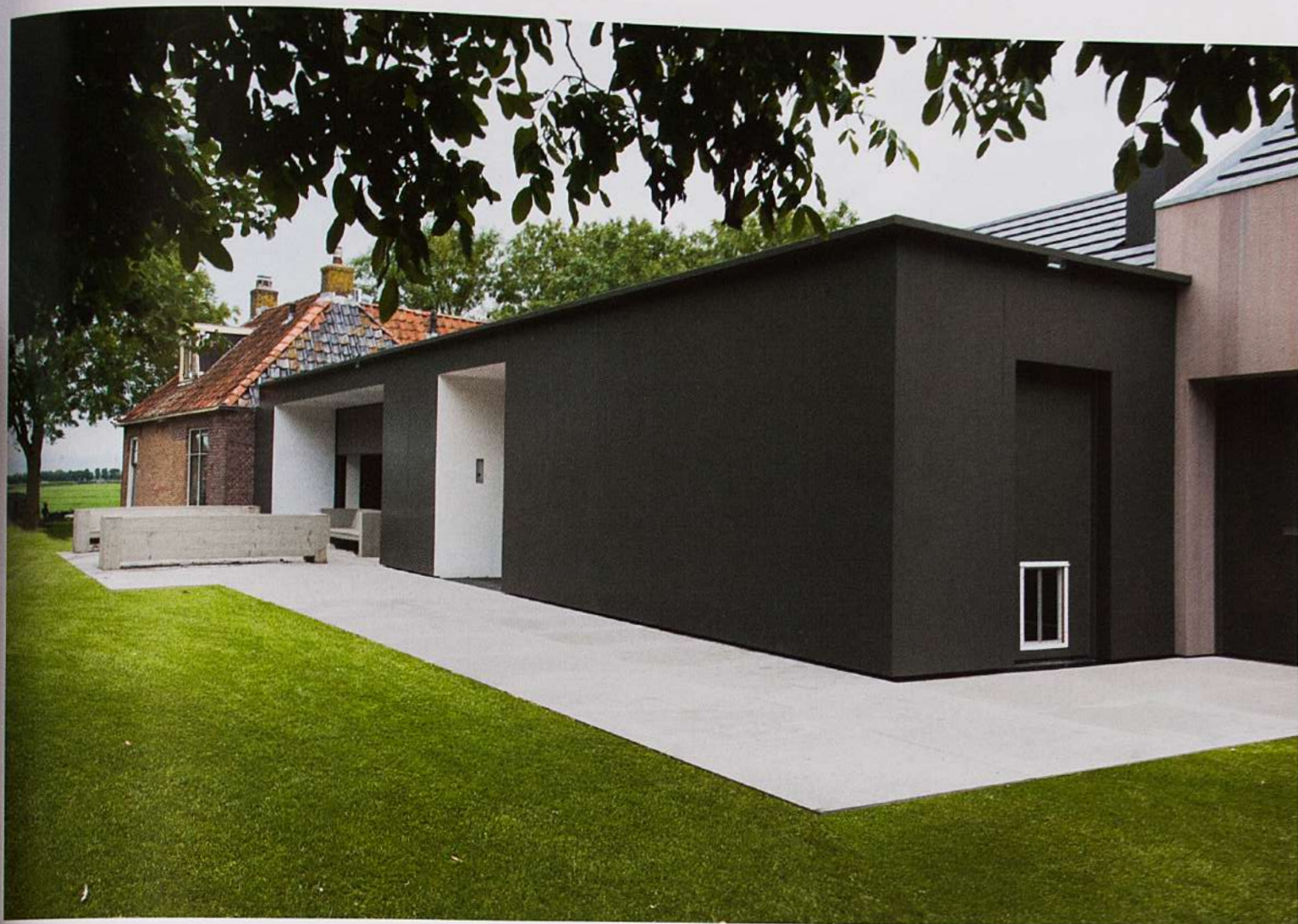
Aanbouw in systeembouw Pro XS, buitenzijde watervast MDF en staal.
