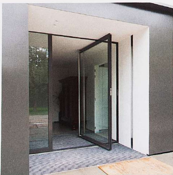
De speciale op maat vervaardigde taatsdeur door Graafstra Oosterwolde vergroot de entree.
